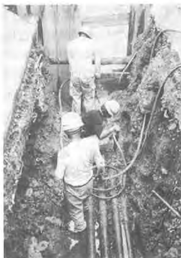
写真-4 地下ケーブルとメーターを結ぶ接続ボックス
