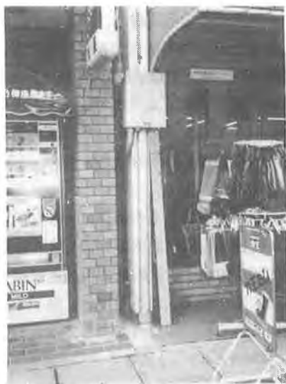
写真-4 地下ケーブルとメーターを結ぶ接続ボックス
