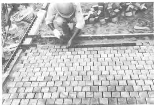
写真-2 木レンガ定規による施工風景
