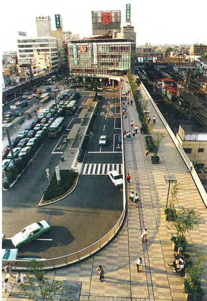
駅前広場と再開発事業（大阪府堺市）
