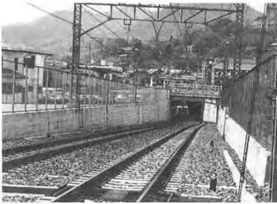
写真—2 長野電鉄、地下入口部
