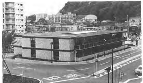
写真一 自転車駐車場（横浜市根岸駅）
