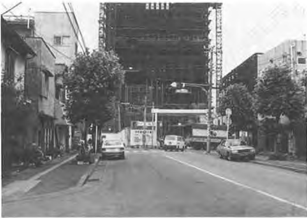
写真一 2 新市庁舎側（まだ沿道は木造の建物が多いが、新市庁舎完成後は建替の可能性が高い）
