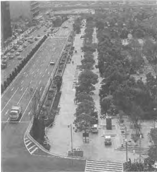
写真－2 緩速車線の一部を歩道化し隣接する東遊園地との一体的整備
