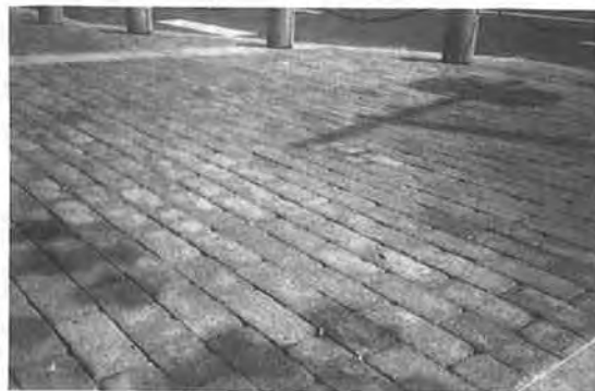
写真-2 土の感触を持たせる舗装
