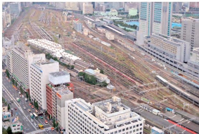
図－3 平成20年頃の品川車両基地
