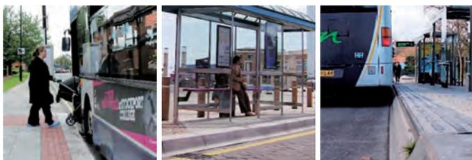
国土交通省においても、基幹的公共交通としてBRTの導入を推進する上で、海外ですでに実用化されている停留所とバス車両の正着性を高める縁石（バリアレス縁石）の国内導入に向けた調査検討に着手しており、平成28年度は国内のバス営業路線において、実証実験を実施しました（写真-2）。
