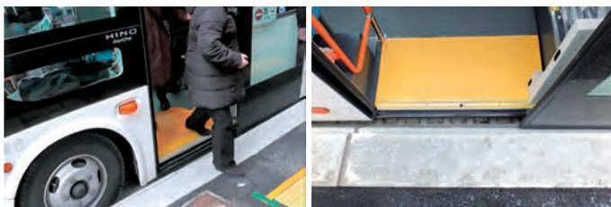
実証実験では、バリアレス縁石導入前後において、停留所とバス車両の水平離隔距離が大きく減少し（図-2）、バリアレス縁石が正着性の改善に有効であることが確認されたほか、設置後、運用時間の経過とともに離隔距離が減少したことから、バス運転手の慣れにより、さらなる正着効果の向上が期待できることがわかりました。
