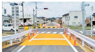
及び鉄道の仮復旧という観点から、交通管理者にご協力いただき、交差道路の幅員や交通量に応じた交差道路側の一時停止あるいは感応式信号機の設置、現示サイクルの調整等により、基本的にはBRT車両の交差点停車なしでの走行が可能となっています。また、専用自動車道の出入口には一般車両の誤進入防止のため、BRT車両から発信する電波により開閉するゲートを設置しています。
