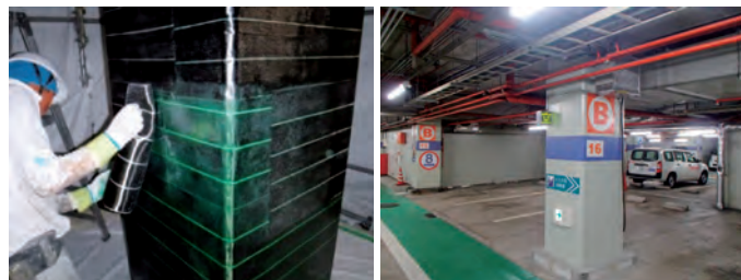
写真－2 炭素繊維巻き工法
