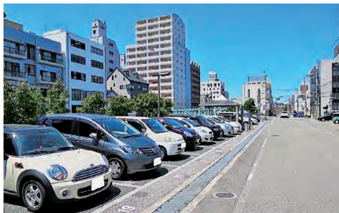
写真－1 市営京橋駐車場
