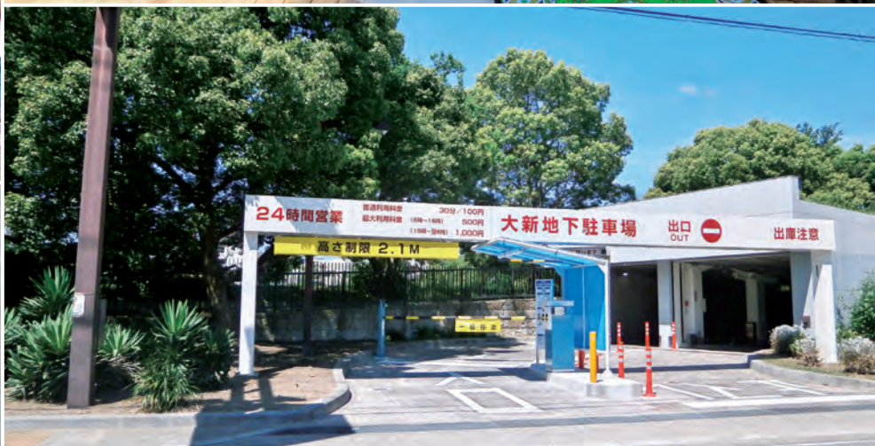
上部が都市公園となっている、再開した大新地下駐車場（和歌山市）
