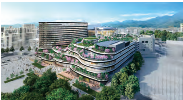
図-2 桜町地区の再開発施設
