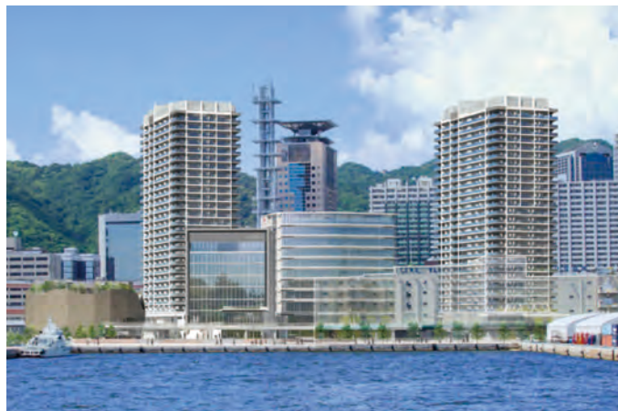
図-8 新港突堤西地区：第1突堤基部の再開発
