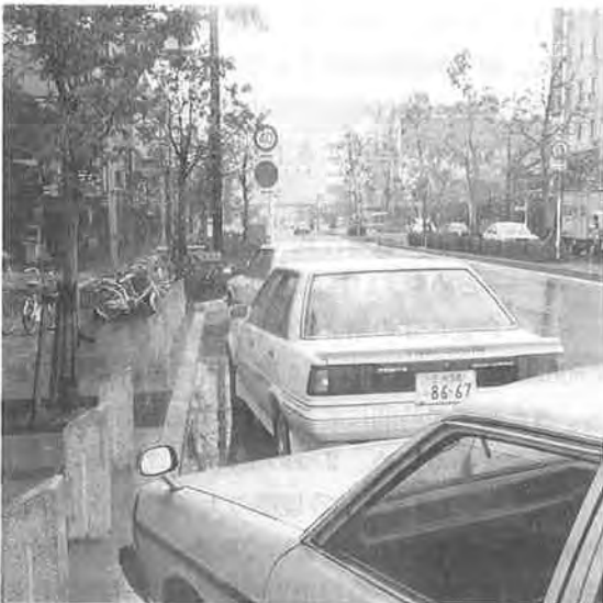
写真—1 電線地中下にあわせ整備された 商店街前の「停車帯」(JR大垣駅前)
