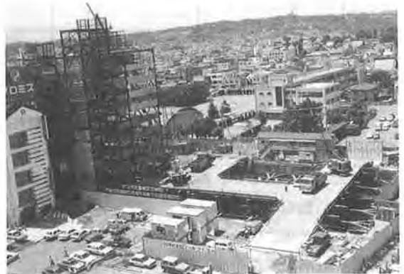
写真-1 建設中の立体駐車場
