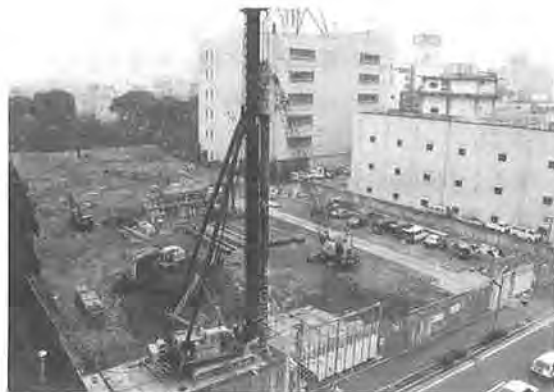
写真一 建設中の地下駐車場
