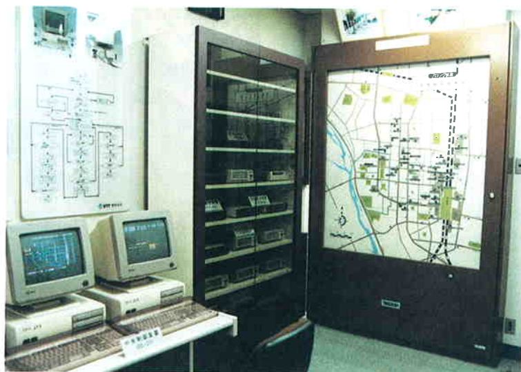
高崎市駐車場案内システム
