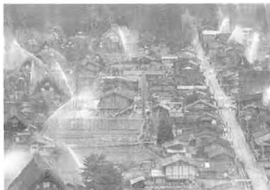
写真—4 白川村菰町の消火訓練
