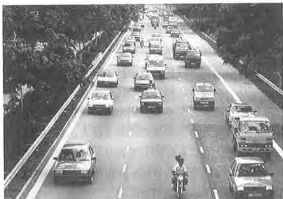
写真一3 高速道路
