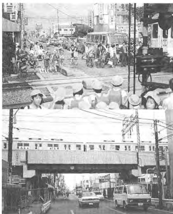
写真一 東武伊勢崎線高架立体前後の金明町鳩ヶ谷橋 (上が昭和55年6月(踏切あり)、下が昭和63年12月(立体 交差後))
