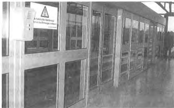
写真一 4 安全性確保のためのホームドア
