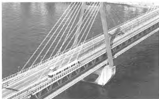
写真—5 六甲大橋添架部
