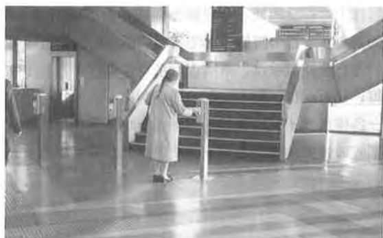
写真一 1 コンコースと自動改札機
