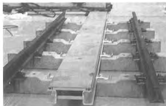
写真-5 レールとリアクションプレート
