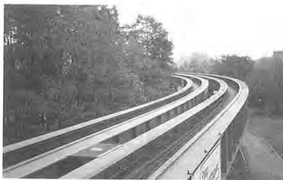
写真-6 スレンダーな軌道部
