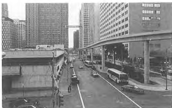
写真－2 スレンダーな構造物 分離帯や歩道部を利用したピアの位置
