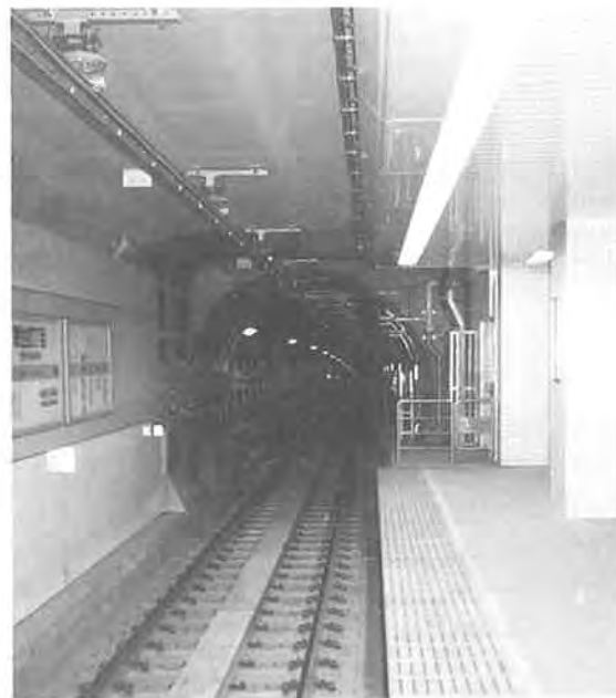
写真-6 シールドの接続部
