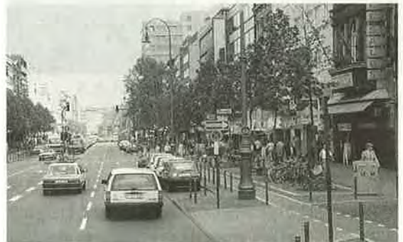
写真二 左から車線—駐車帯—自転車道—自転車駐輪帯—歩道(ケルテン市)
