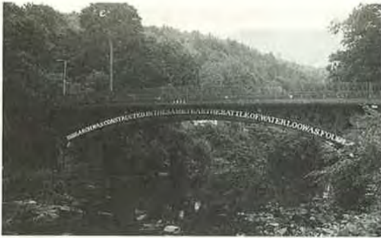
写真-4 北ウエールズのワーテルロー橋
