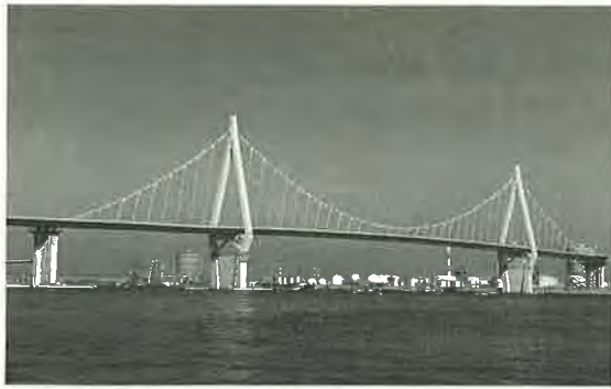
写真一 此花大橋（平成2年完成）
