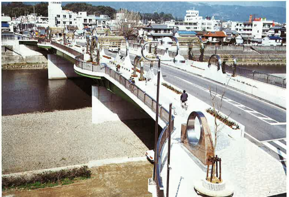
橋梁整備 高知市：新月橋通り線(新月橋)
