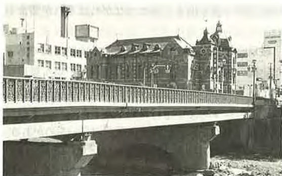
写真三 中の橋（昭和31年完成、54年改装）
