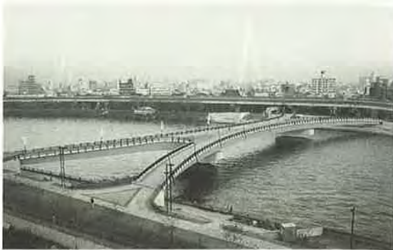
写真一六 桜橋（昭和60年完成）
