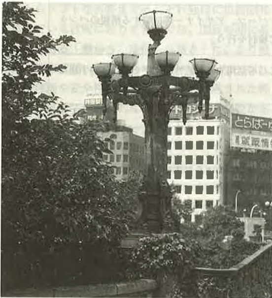
写真-1 四谷見附橋橋灯
