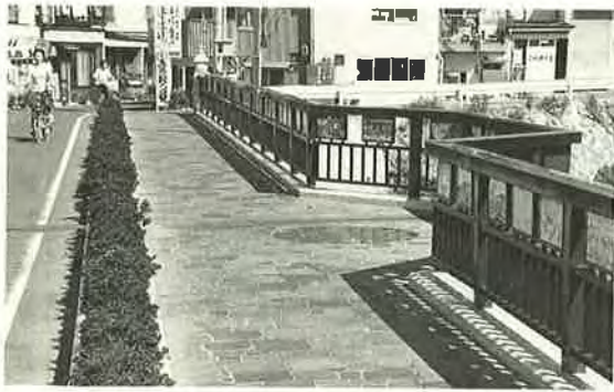
写真一七 大井橋（昭和59年完成）
