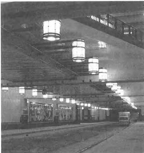
写真一六 シアトルのバストンネル(駅部)低床式ホーム、一階上がコンコース、その上が市内幹線街路(90年3月現在建設中)
