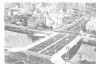
風の橋（中島橋）平成4年7月完成
