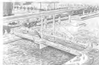
音の橋（豊後橋）昭和58年10月完成
