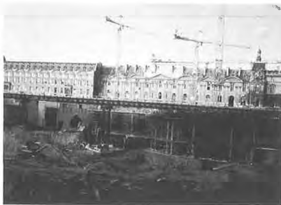
写真一 1 パリ市内 景観を大切にするため、地下に大規模な立体駐車場を建設
