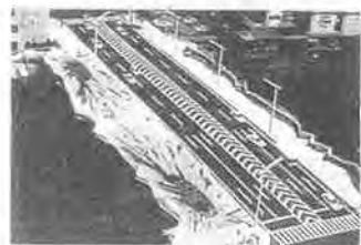
太陽の橋（中の橋）平成4年5月完成
