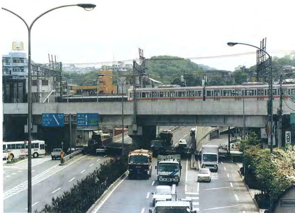
連続立体交差事業による渋滞解消の例（東京都八王子市）
