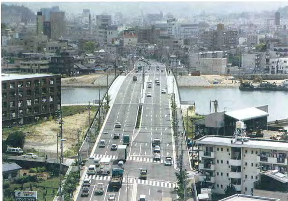
橋梁整備事業による渋滞解消の例（広島市）
