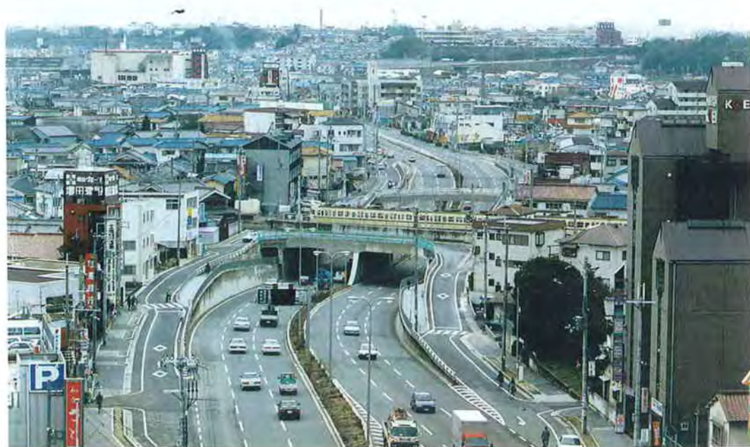
立体交差事業による渋滞解消の例（兵庫県川西市）
