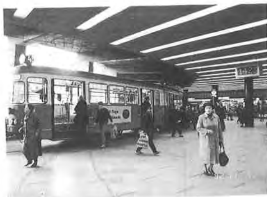
写真-6 ショットントーア駅の地下広場（1961年完成）
