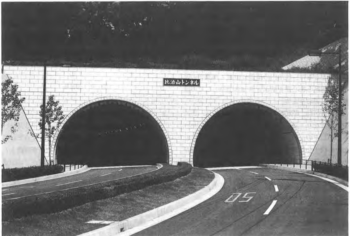
写真一 比治山トンネル写真
