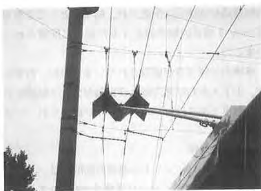
写真－9 EVAGスパーバスのパンタグラフ（架線からの集電）
