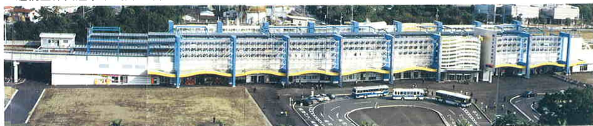
▼日豊本線宮崎地区 連続立体交差事業 (宮崎県)
