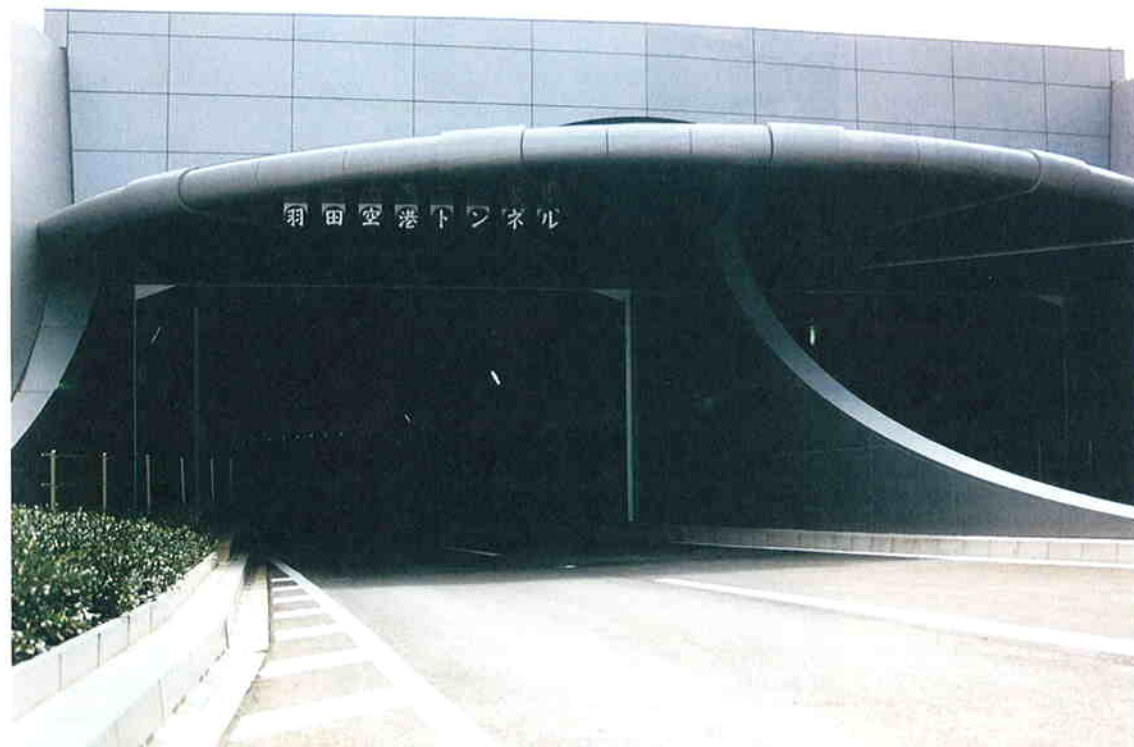
都市計画道路幹線街路環状8号線 羽田トンネル整備事業 (東京都)
