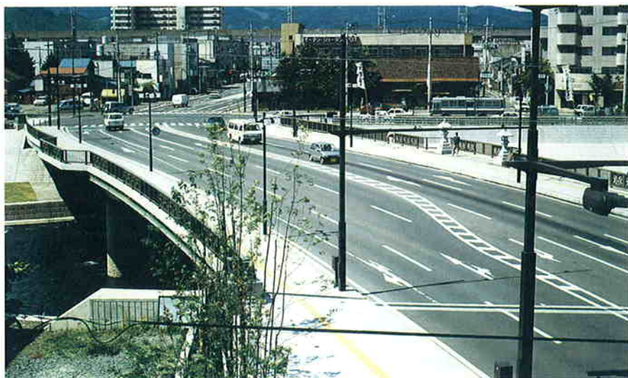
▶ 都市計画道路 向中野安倍館線 夕顔瀬橋架換整備 事業（岩手県）
