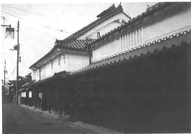
写真－2 重厚な町家の続く今井町の町並（奈良県）
