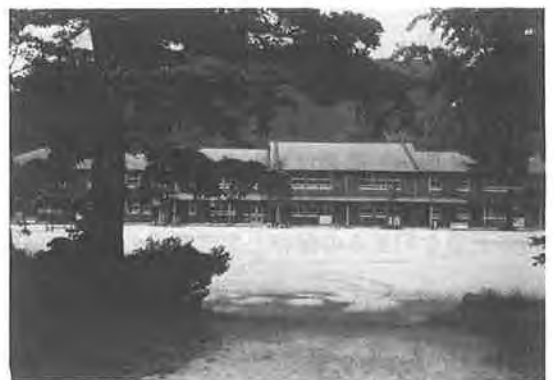
写真—8 木造校舎に建て替えられた秋月中学校
