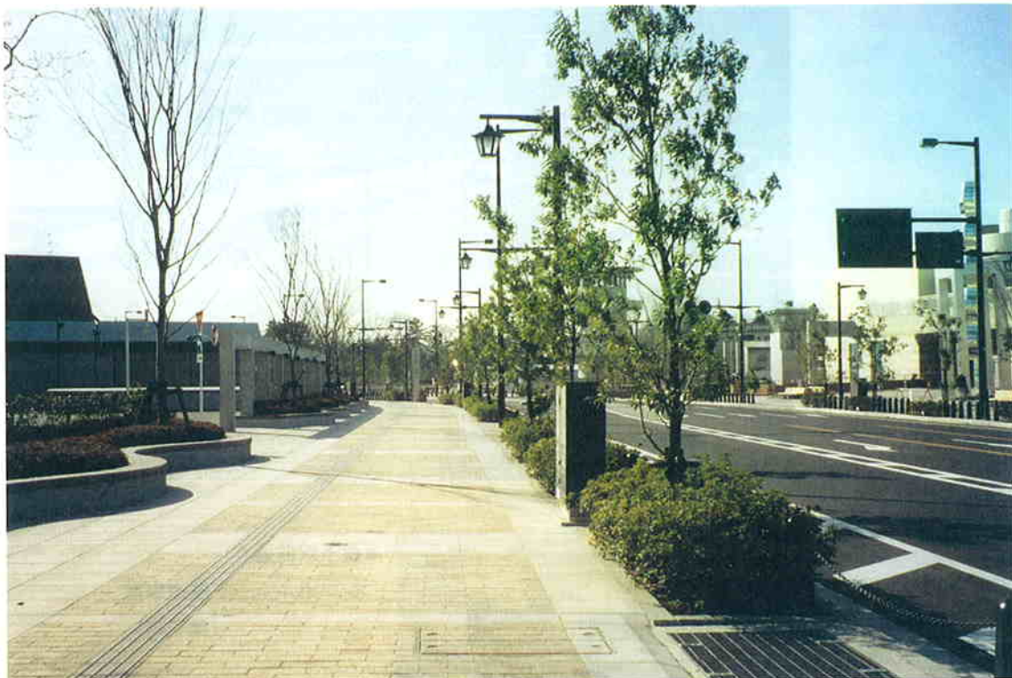
都市計画道路高崎駅西口線 緊急地方道路整備事業（群馬県）
