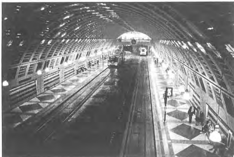
写真—3 シアトルの地下バス・トンネル
