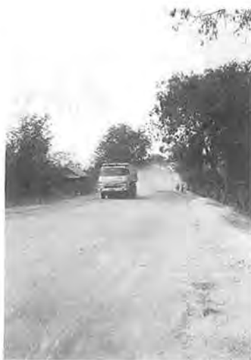
写真-1 堤防道路の状況
