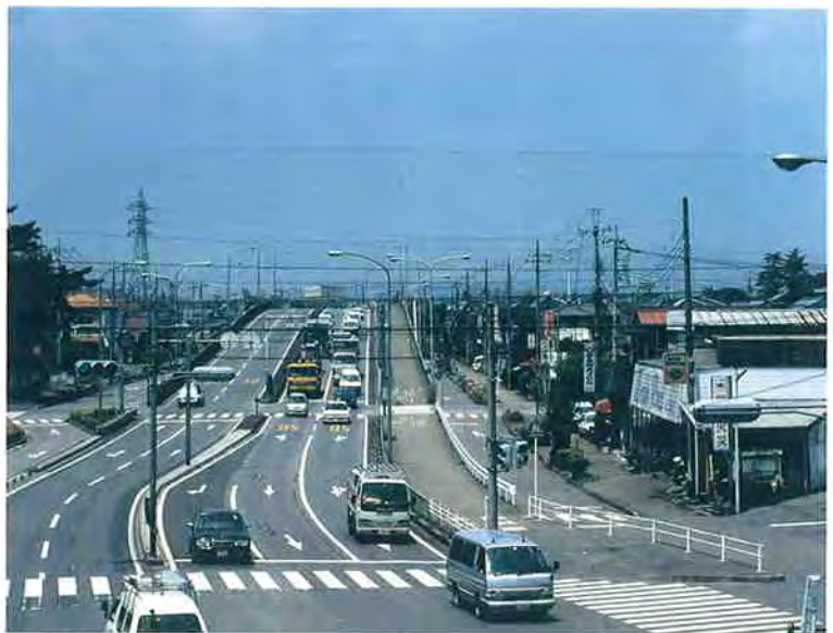
▲西川田跨線橋（東武宇都宮線立体交差）（図中⑥）
