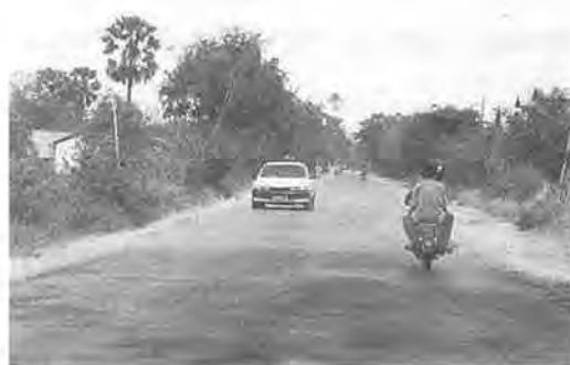
写真-4 同じ国道5号線の未改良区間
