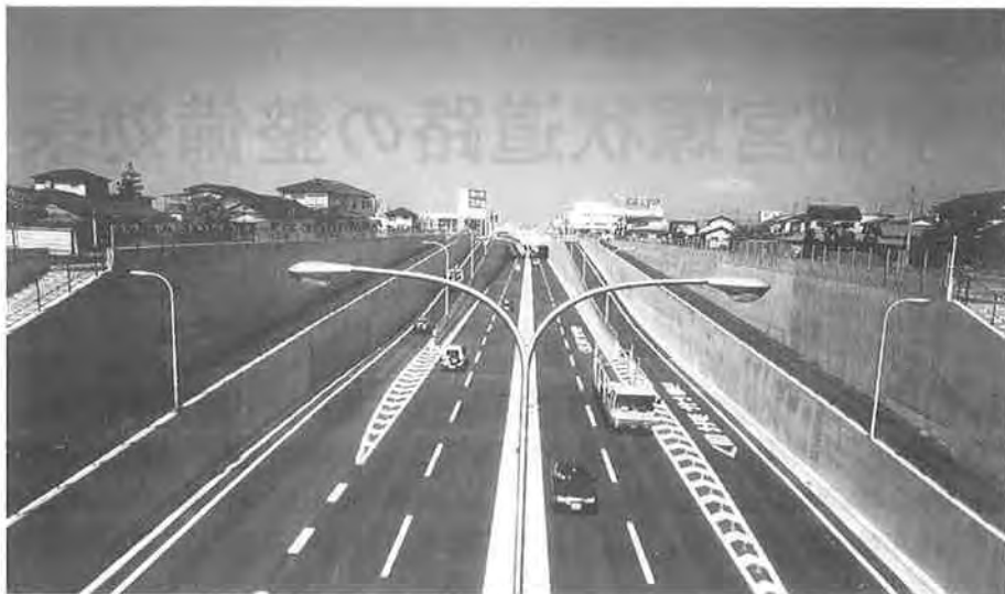
写真—1 宇都宮環状道路（国道4号及び宇都宮線立体）
