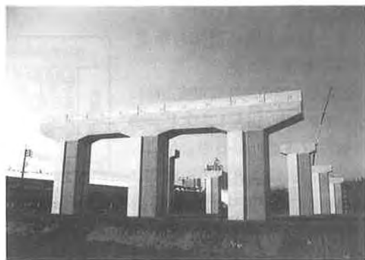
写真-1 街路事業で整備中の宇品ランプ
