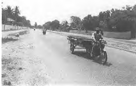
写真-3 市街地へ続く国道5号線の舗装状況 (RCCにより改良された区間)
