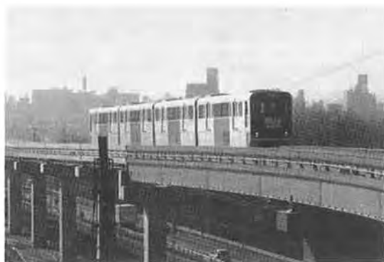
写真－1 試運転中の多摩都市モノレール
