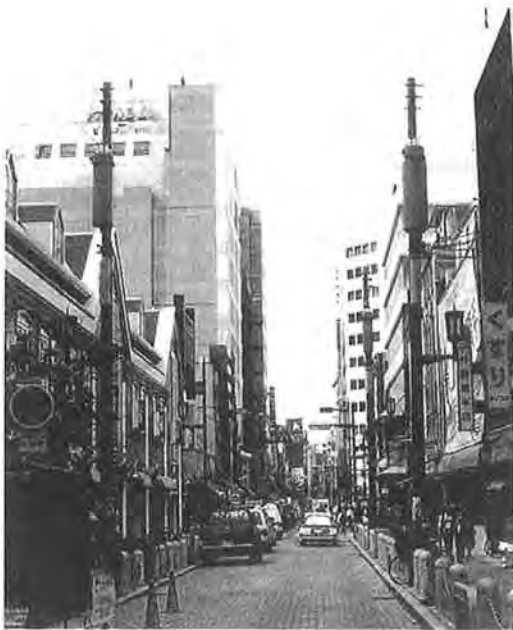
図一4 周防町通りにおける実施状況
