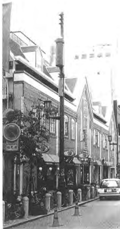
図一３ 周防町通りにおける共用柱
