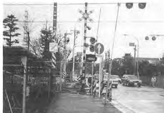
写真ー1 未改良踏切
