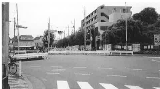
写真—3 環 8 から通行止の補助172号線を望む
