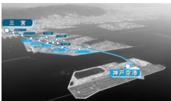
神戸新交通ポートアイランド線延伸事業
