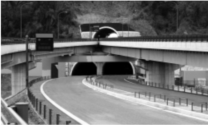
写真 - 1 三つ目トンネル
