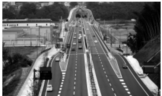
写真 - 2 開通後の状況（大桑高架橋、崎浦涌波トンネル）
