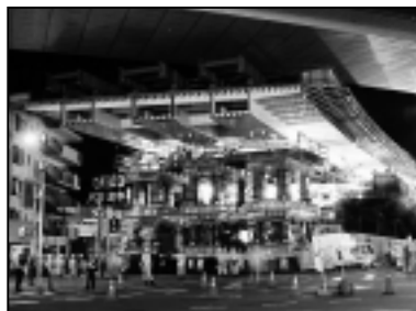
図－4 板橋相生陸橋：架設状況
