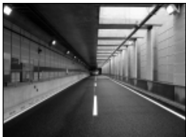
図－3 半地下式トンネル
