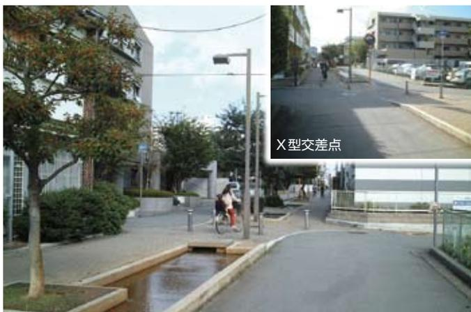
交差点にはイメージハンプを設けるなど、車の速度を抑える工夫をしています。石畳風の車道舗装とアーチ型の照明灯などにより、個性的な道路空間を演出しています。
