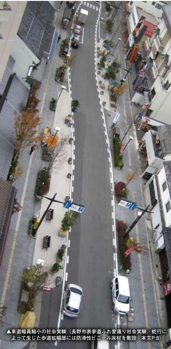
▲車道幅員縮小の社会実験（長野市表参道ふれ愛通り社会実験／蛇行によって生じた歩道拡幅部には防滑性ビニール床材を敷設 本文P.8）
