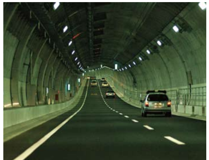
図－2 山手トンネル
