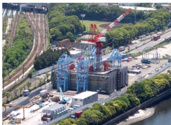
図-4 大井北発進立坑
