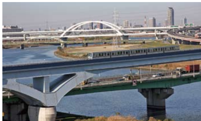
図－4 荒川横断橋梁
