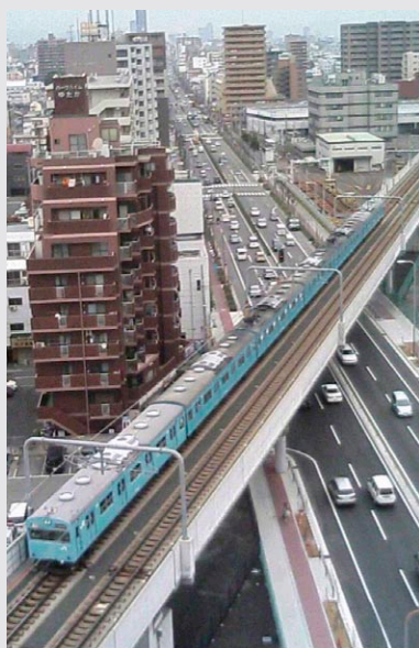
JR 阪和線連続立体交差事業
