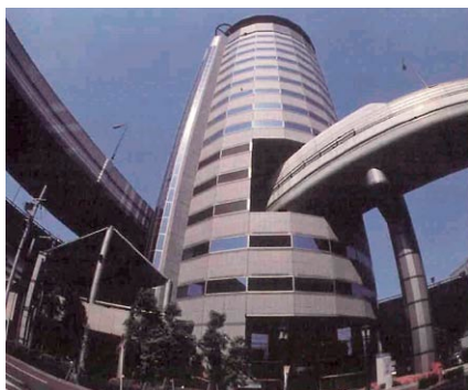
図－1 立体道路（阪神高速梅田出路西梅田ゲートタワービル）
