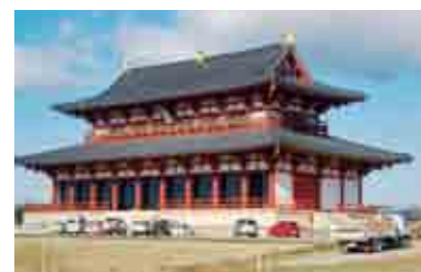
写真-1 工事中の第一次大極殿
