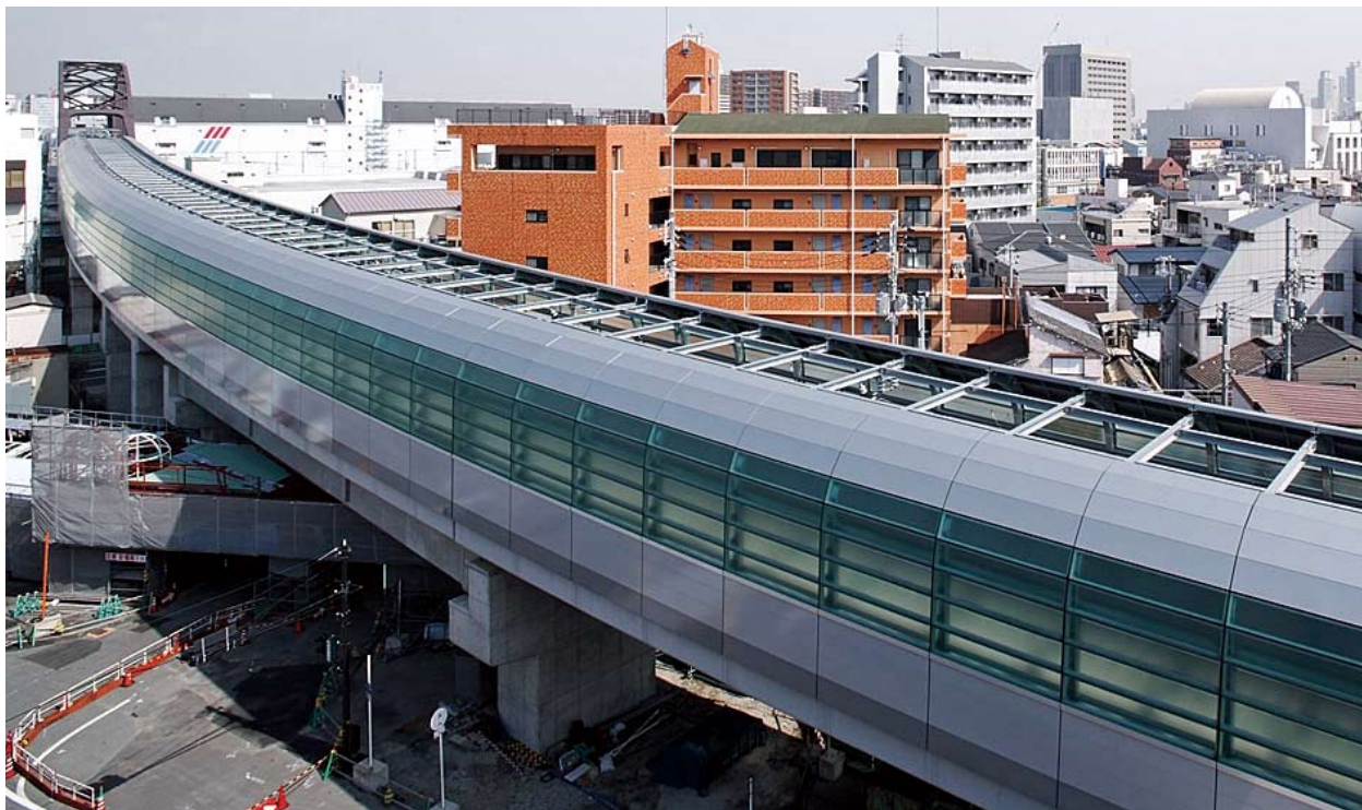
写真-1 セミシェルター型防音壁
