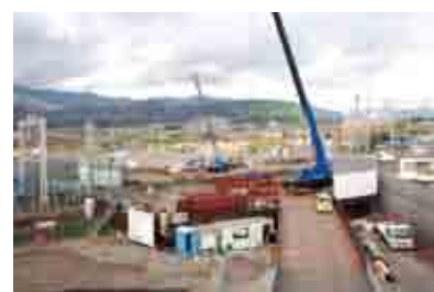
写真-2 新駅予定地の現況 (にそと工事を先行実施中)
