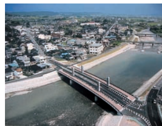
写真-1 都市計画道路 八尾駅上井田新線
