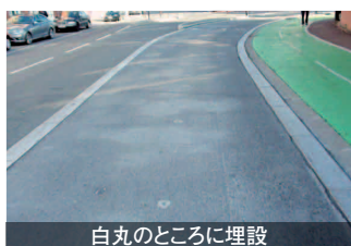
写真－１０ 磁石によるガイド
