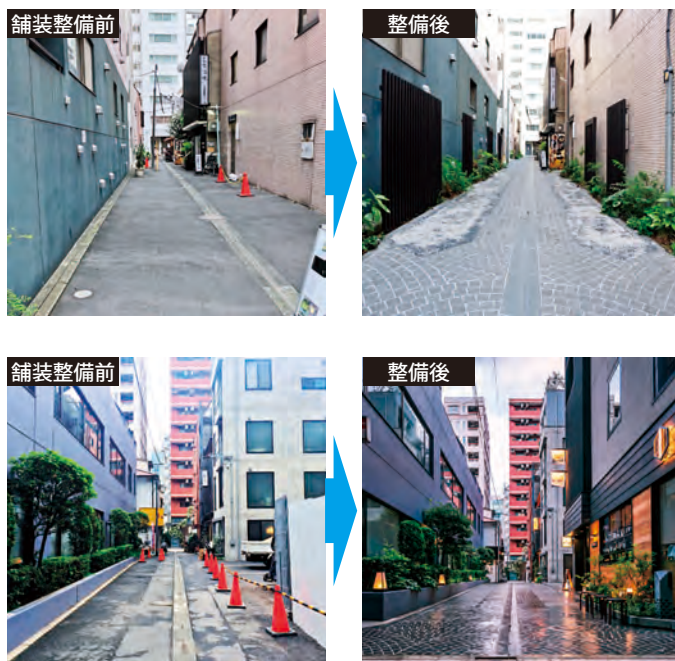
写真-1 先行運用地区の路地舗装整備
