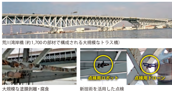
大規模な塗膜剥離・腐食
