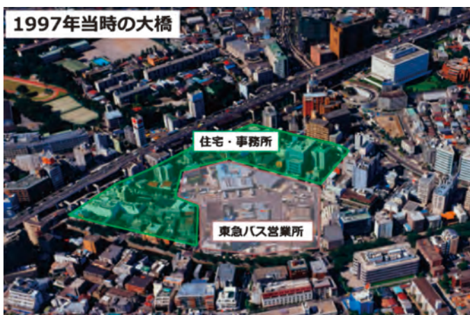
写真－1 建設前の大橋JCT周辺
