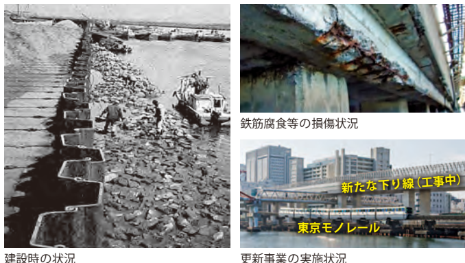
建設時の状況
