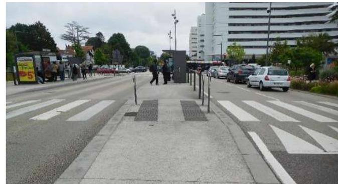
バス停の直近に横断歩道を設置し、どちらのバス停にも短い距離でフラットにアクセスできる。
