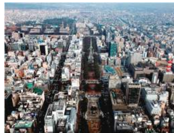
再整備工事着手前の久屋大通
