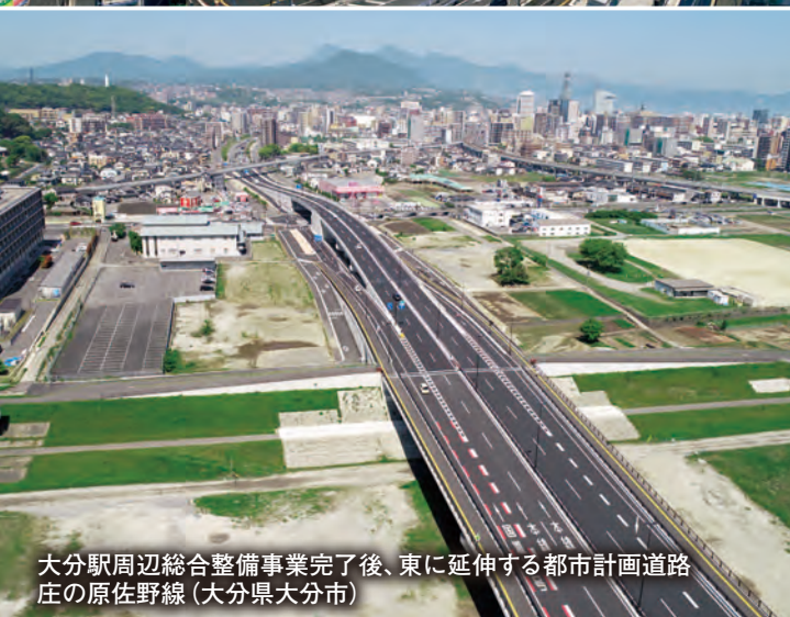
折尾駅周辺連続立体交差事業（北九州市）
