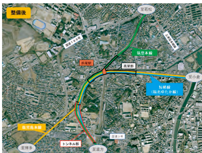
写真-2 整備後の航空写真
