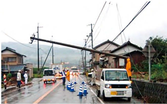
写真－１ 沿道民地の電柱が倒壊し道路閉塞した例
