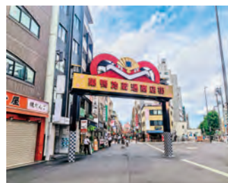
写真-2 新アーチ看板（抜柱後）
