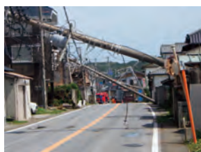
2019年台風第15号による電柱倒壊
