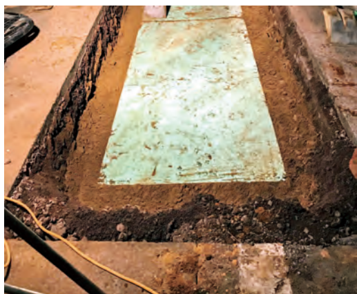
写真－3 EPS施工状況
