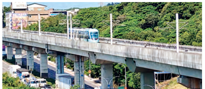
写真-4 淡海LRTにおける高架区間
