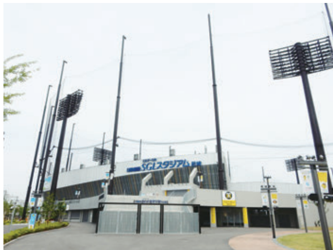
図-5 日鉄鋼板 SGLスタジアム尼崎
