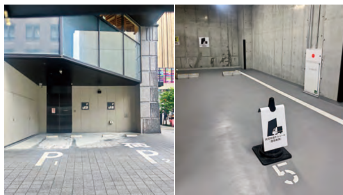
写真－3 共同荷さばき駐車施設の設置事例
