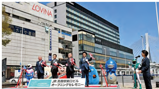
写真－2 JR青森駅東口ビル
